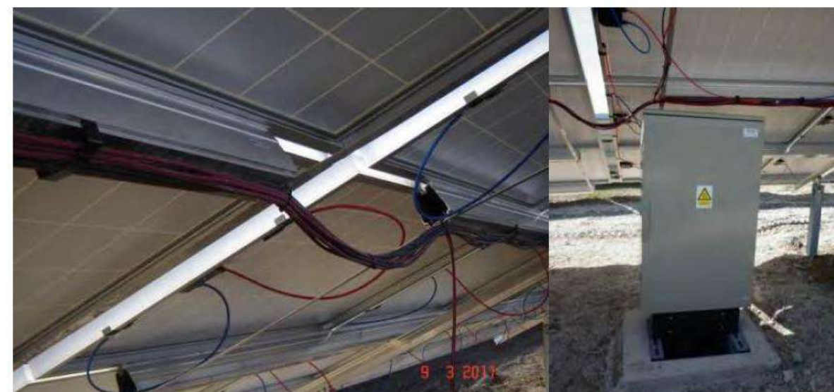
Illustration des boîtes de jonction et de raccordement
