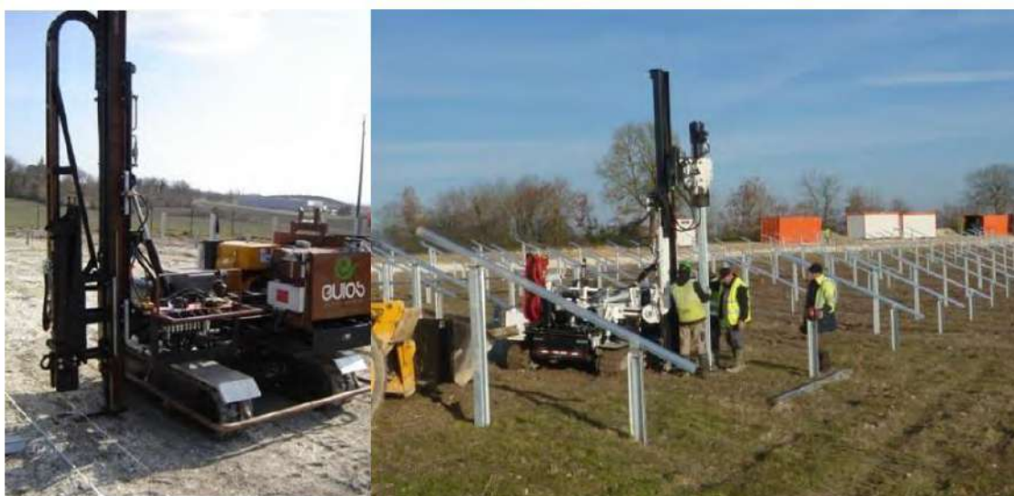
Battage des pieux
