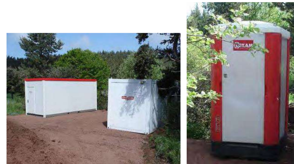
Vestiaires et bureaux de chantier et exemple de sanitaires
