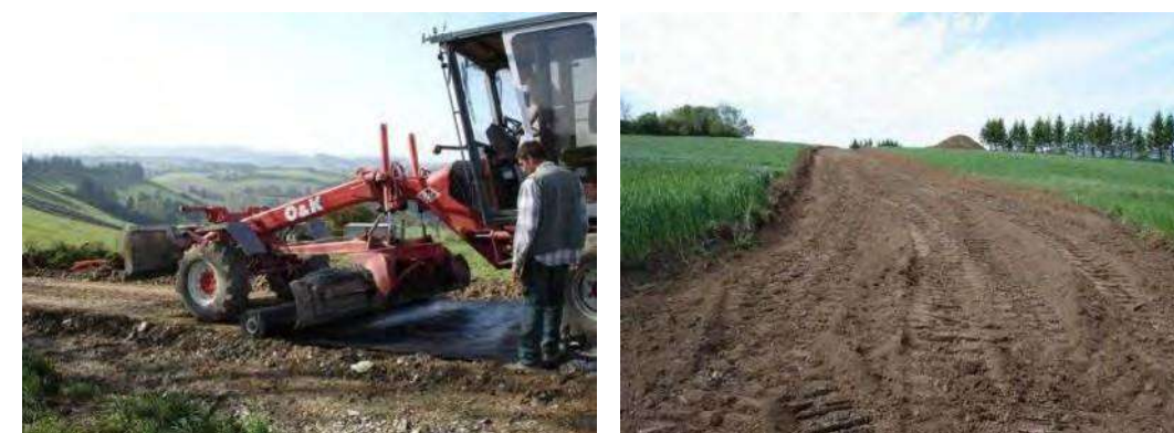
Tracé de la piste et décapage et pose du géotextile (cas d'un parc éolien)
