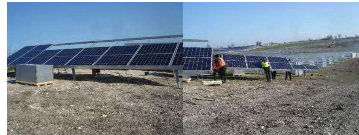
Pose des modules, centrale solaire du Sycala (46)
