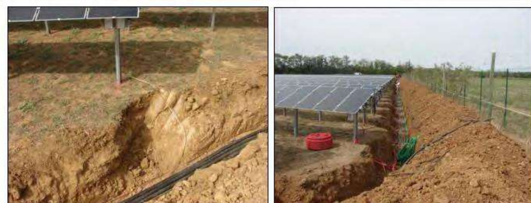
Tranchée drainant le courant continu
