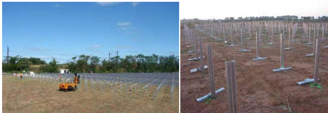
Battage des pieux et aspect des supports
