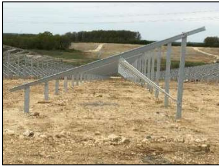
Figure 94 : Exemple d'une structure porteuse complète avant la mise en place des panneaux
