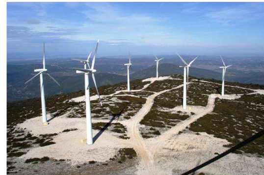
Plus grand parc éolien de France lors de sa construction - L'un des parcs les plus productifs de France.
