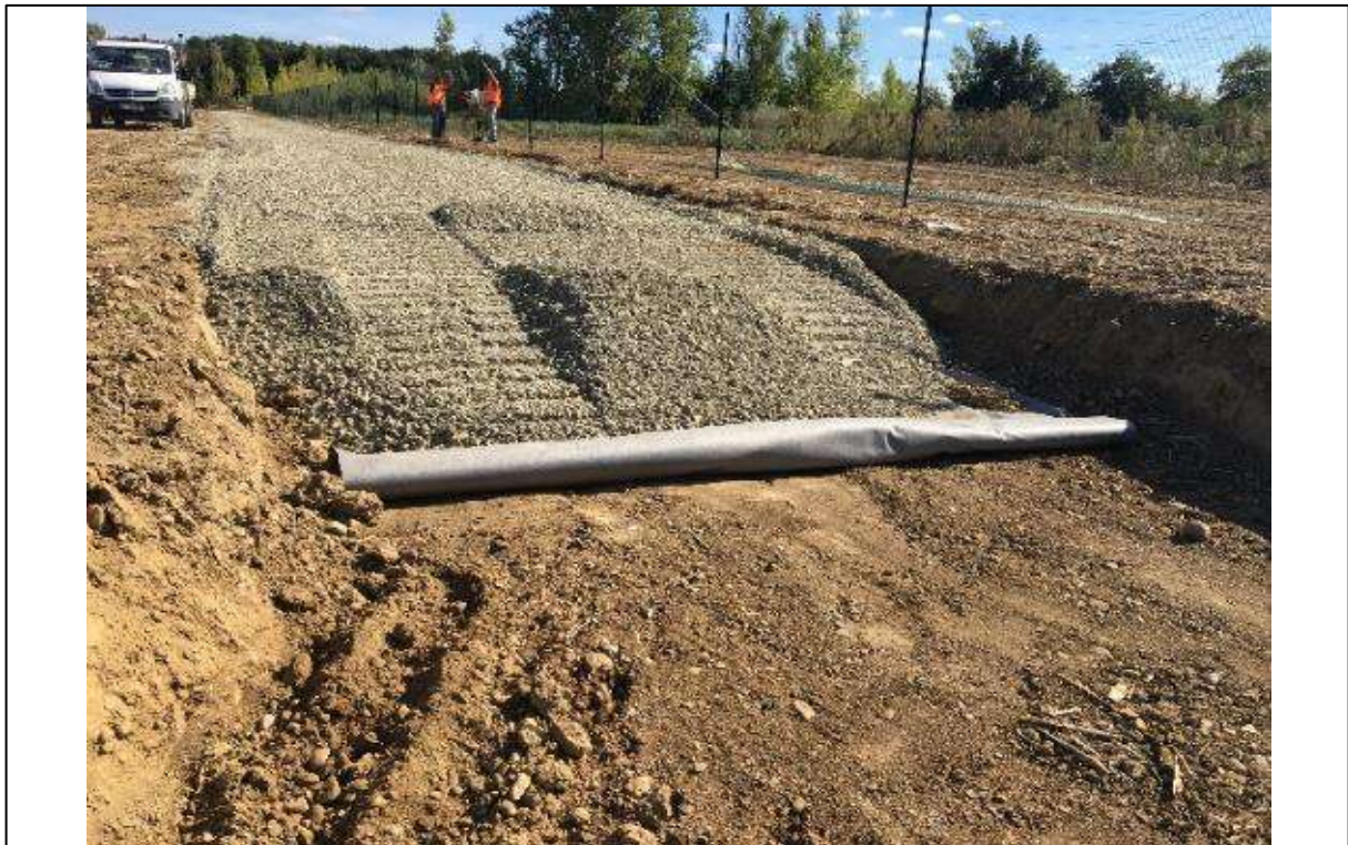
Figure 93 : Exemple de réalisation de voie d'accès interne
